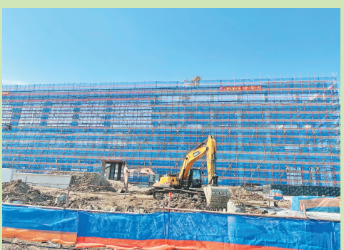
新黑河站站房建设工地现场。
