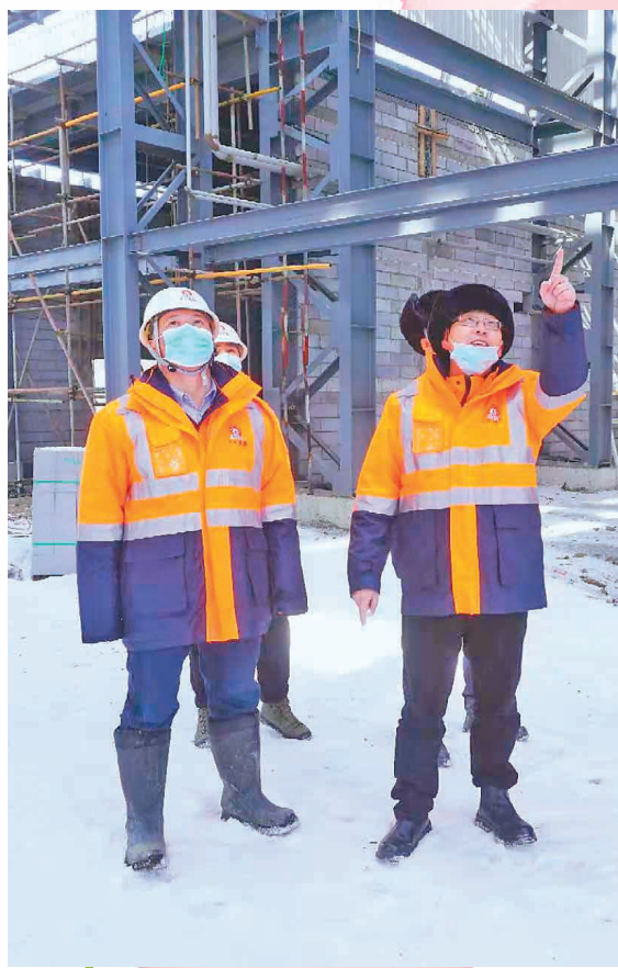
中国五矿鹤岗石墨产业一体化项目建设现场。
