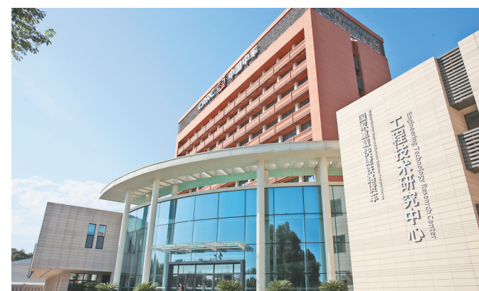
国家重载快捷铁路货车工程技术研究中心。黑龙江日报全媒体记者 朱云峰摄
