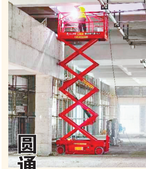
项目施工现场。
