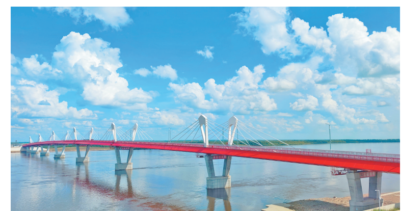
建投集团承建的黑河——布拉维申斯克黑龙江（阿穆尔河）大桥。图片由建投集团提供
