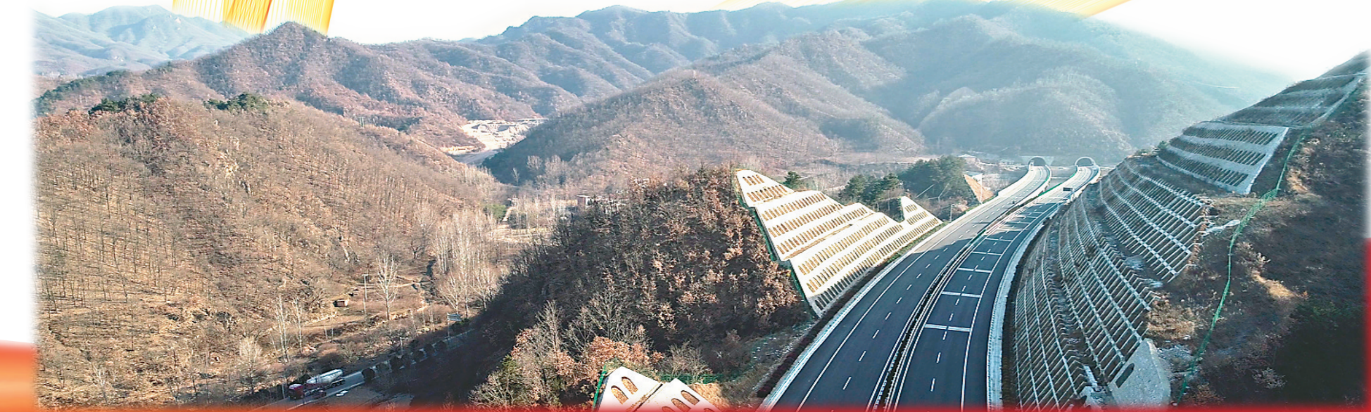
河南郑州双桥黄河大桥
