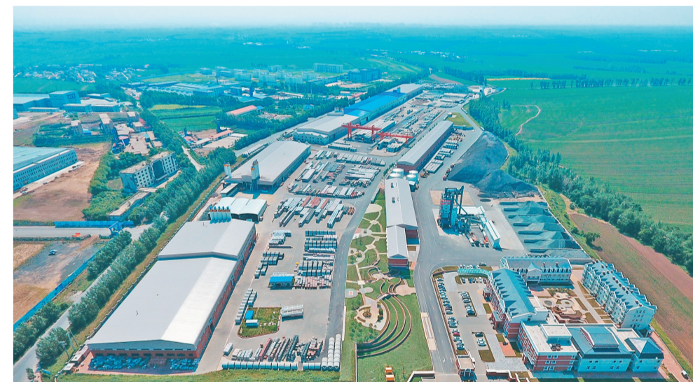
百万平方米黑龙江建筑产业现代化示范园
