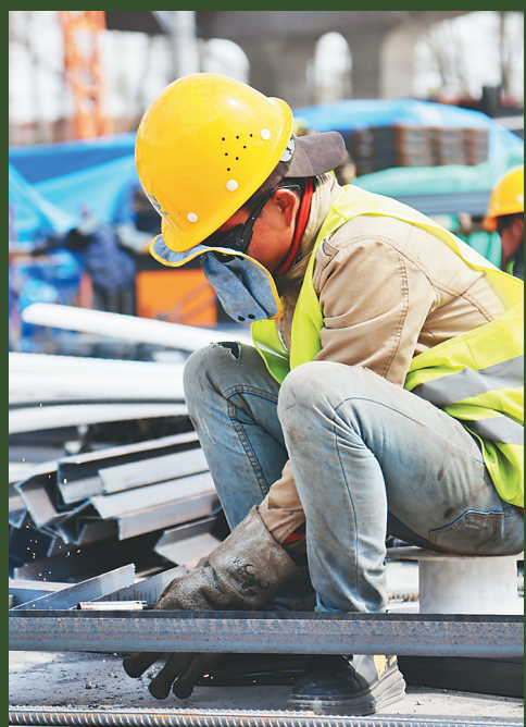
项目建设开春即开工。资料片
