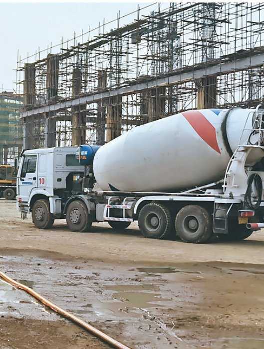
迪诺医药中间体项目建设现场。
