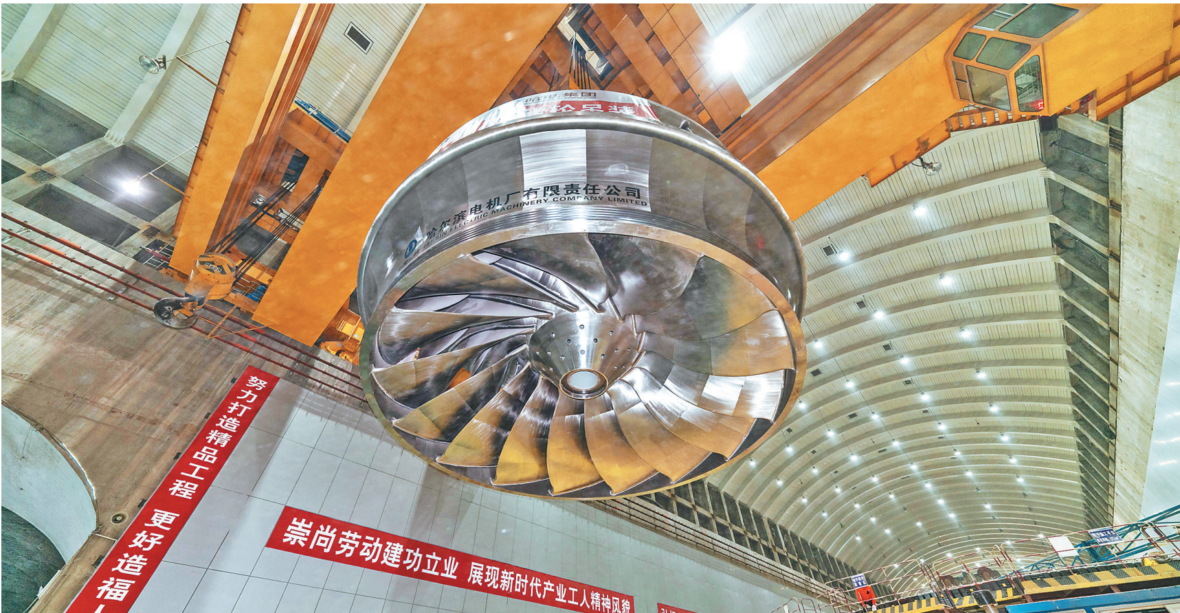
白鹤滩水电站16台100万千瓦水轮发电机组转轮全部吊装完成。图片由受访单位提供
