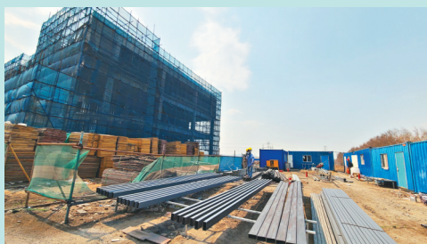
项目施工现场。
