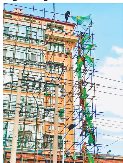
向阳区老旧小区外立面改造。杨俊成摄
