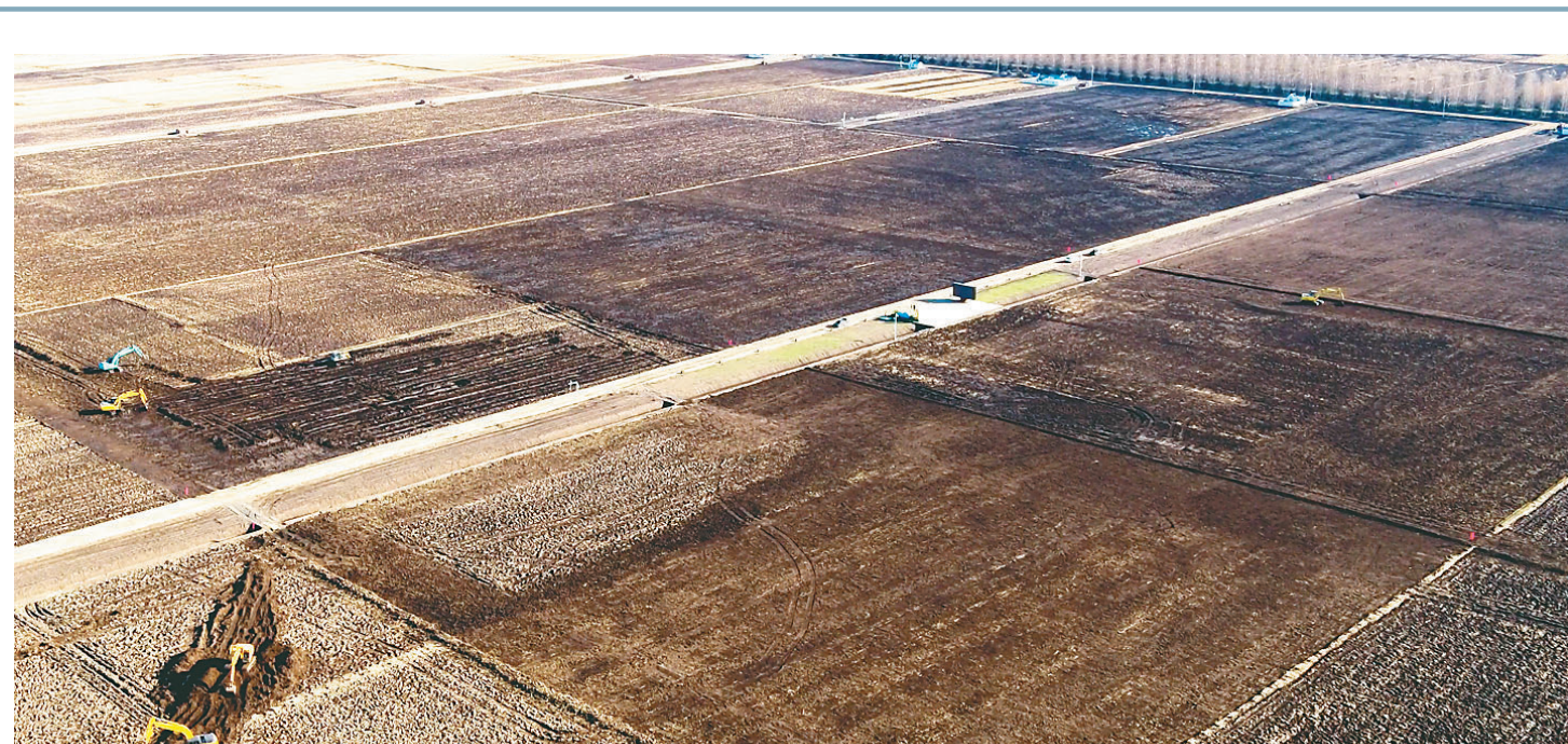
格田改造作业现场。
