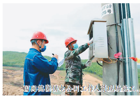
国网鹤岗供电公司工作人员进行施工。
