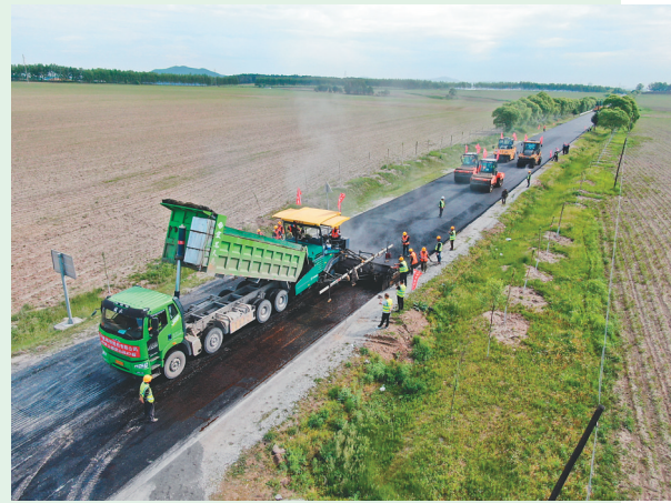
施工机械铺装路面。
