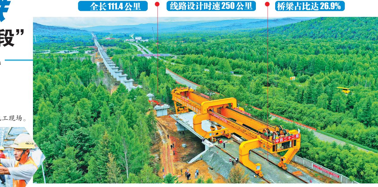
本报30日讯(记者狄婕)记者从中国铁路哈尔滨局集团有限公司获悉,30日10时16分,在我省哈伊高铁铁力至伊春段S207省道2号特大桥施工现场,随着施工人员操作架桥机启动首榀预制箱梁的架设工作,哈伊高铁铁伊段建设正式进入架梁施工阶段,为后续全线铺轨奠定了坚实基础。
