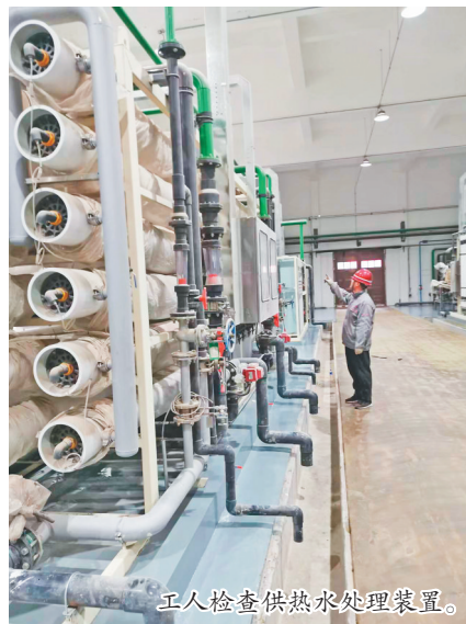
工人检查供热水处理装置。
