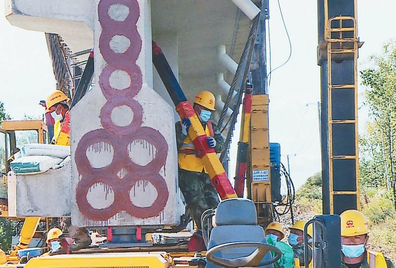
近日,北黑铁路升级改造工程永青村大桥施工现场,最后一片32米长T梁成功架设,这标志着北黑铁路升级改造工程站前二标段T梁架设任务圆满完成。
