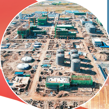
↓新产投集团总投资近70亿元的聚碳酸酯联合项目建设现场。
