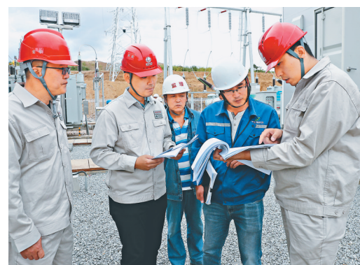
七台河供电公司员工对黑龙江联顺生物科技有限公司新建110千伏变电站进行验收。
