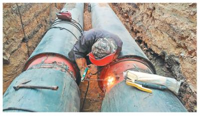
向阳区煤建路DN600供热管线焊接现场。
