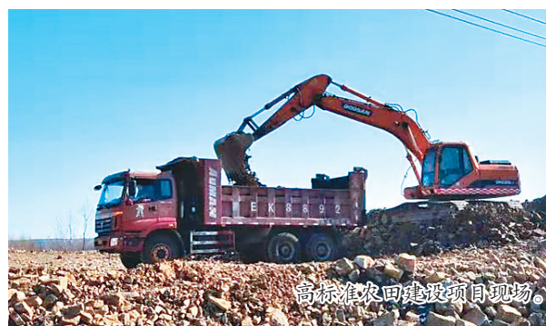
高标准农田建设施工现场。
