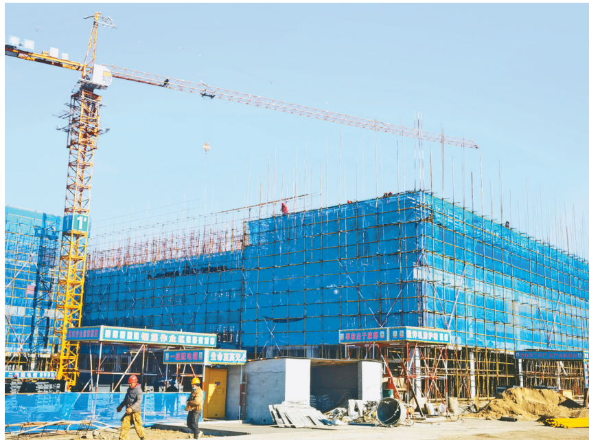
施工现场。路久宽 本报记者 姚建平
