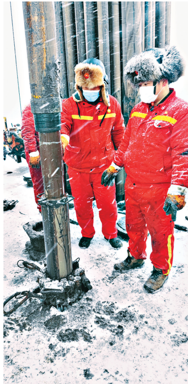
施工现场。图片由受访单位提供
