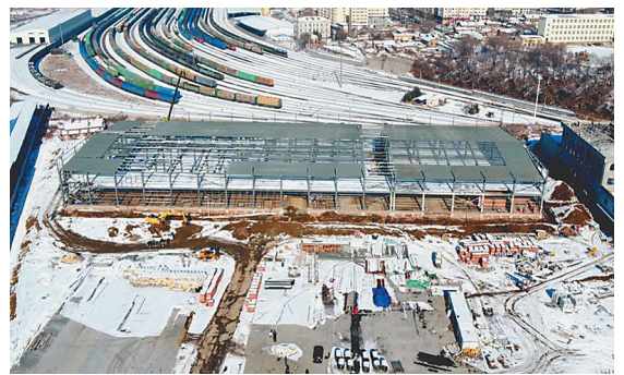
绥芬河市首站进口冷链商品物流集散港项目建设现场。
