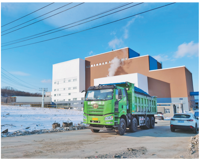
鹤岗市1×12MW生活垃圾焚烧发电项目。本报记者 王白石摄
