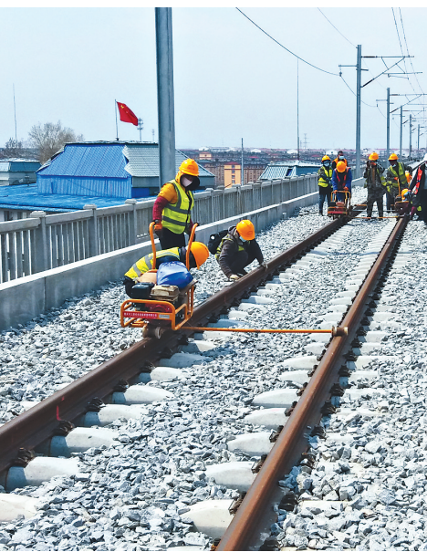
精调钢轨施工。图片由受访单位提供
