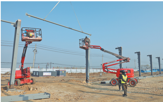
隆基绿能高效单晶组件项目正在进行成品库厂房钢结构安装。
