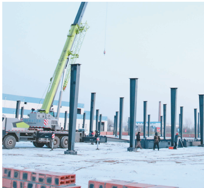
华润三九中医药产业项目现场。 宋洋摄
