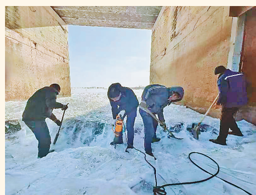
破除闸口底部冰层,加快提闸蓄水进度。王立彬 褚星池 摄
