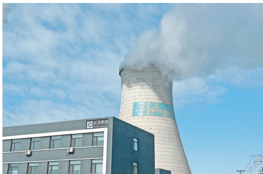
宾县长青生物质热电联产项目冷却塔。
