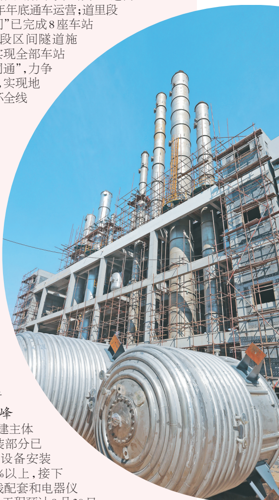
大庆汉光新材料生产设备安装现场。
