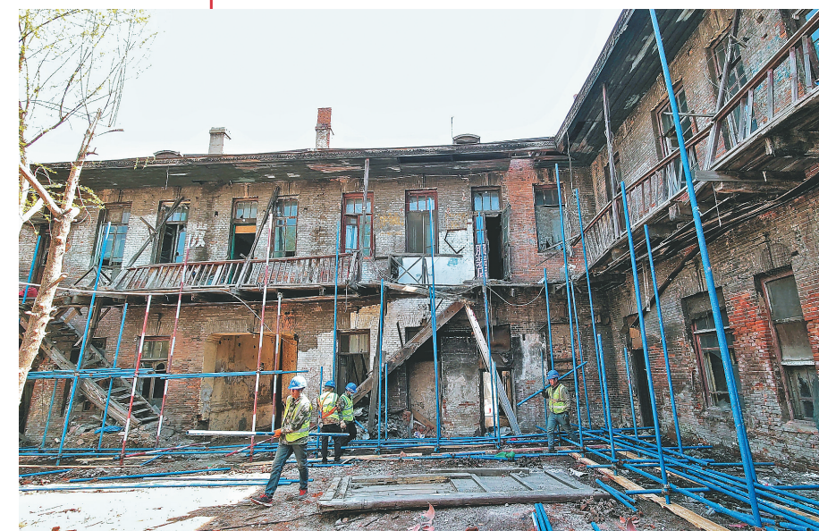
中华巴洛克三期改造现场。
