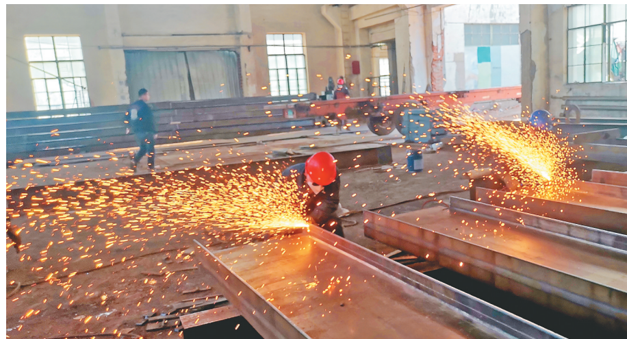
碳一施工现场火花四溅。
