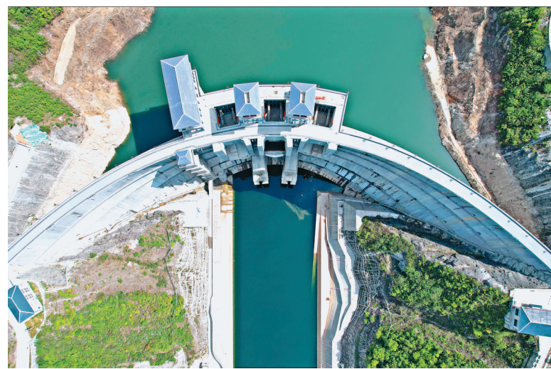
引汉济渭工程三河口水利枢纽工程(2022年4月19日摄,无人机照片)
