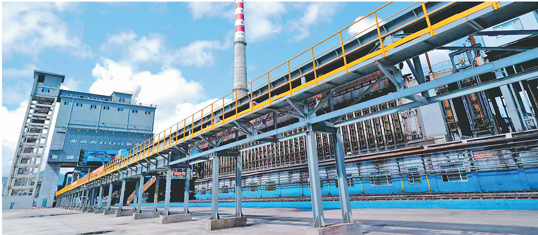
建龙西钢140万吨焦化项目。
