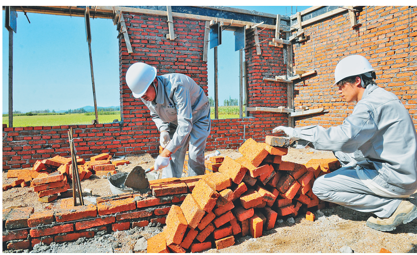
龙王庙村村民赵志山家的水毁房屋正在重建。
