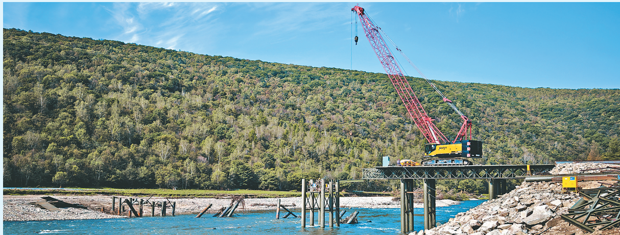
水毁后重建现场。
