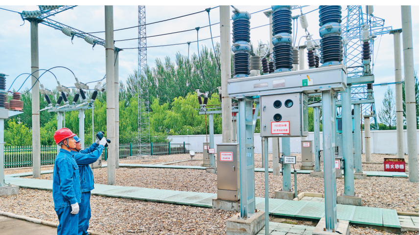
国网黑龙江省电力有限公司富裕县供电分公司开展秋检前安全隐患排查工作。王新宇摄
