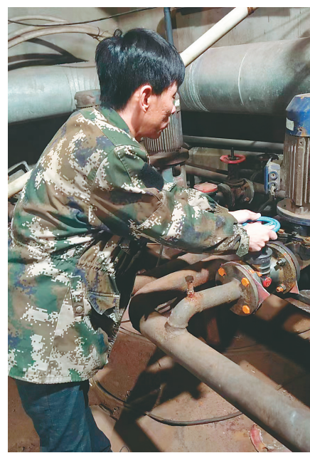
金铁检查供暖设备。
