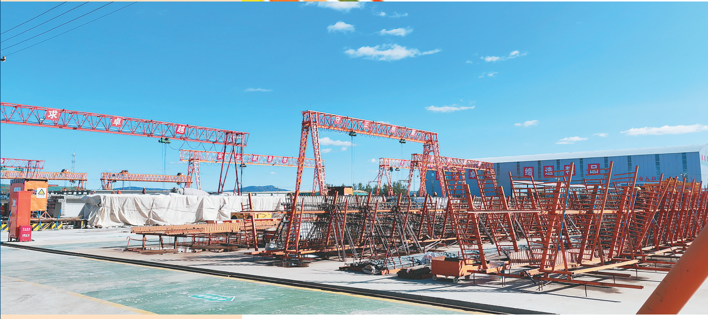
鹤伊高速苍青至伊春段抓梁施工。本报记者贾红路摄
