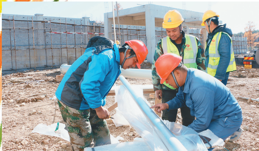
铁力200兆瓦风电项目建设紧锣密鼓。刘博摄
