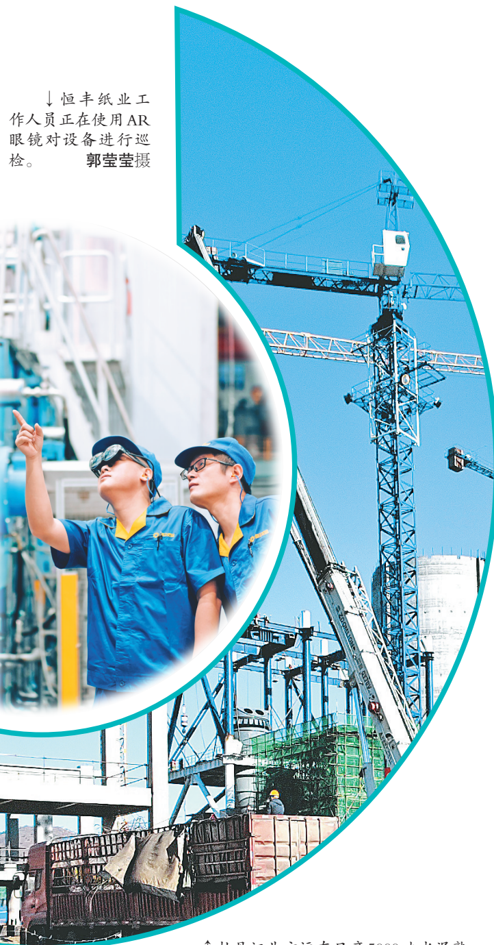
↑牡丹江北方远东日产5000吨水泥熟料项目施工现场。 本报记者 刘晓云摄
