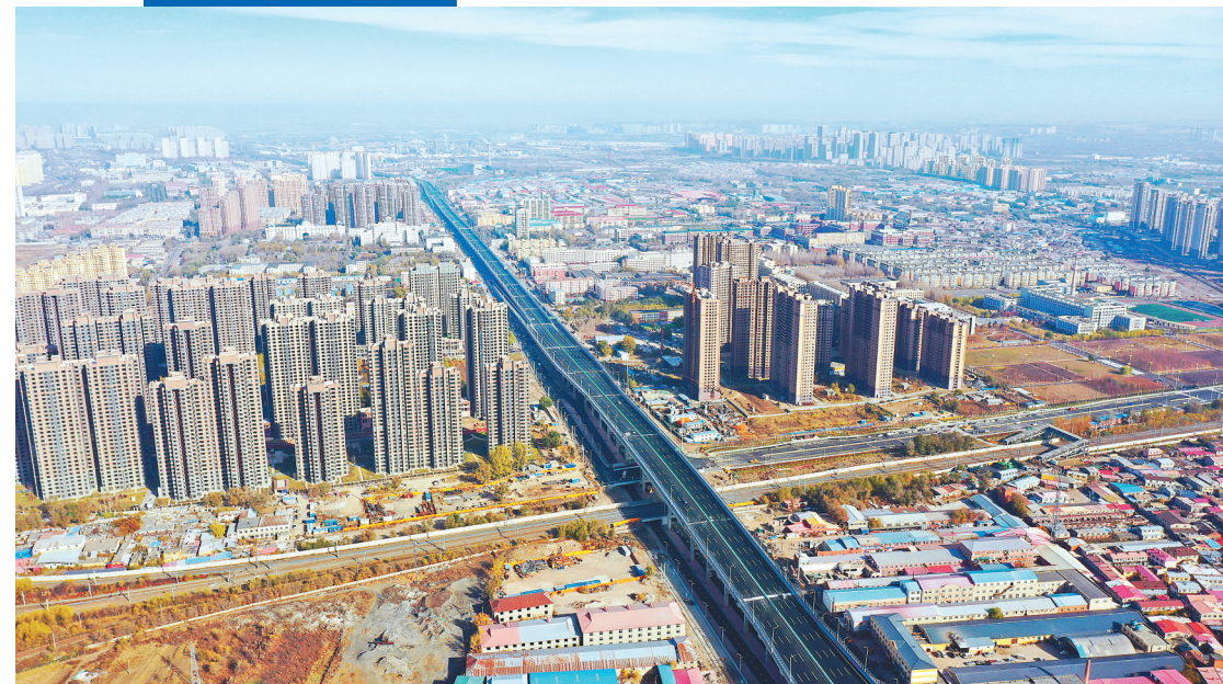
东三环快速路俯瞰。
