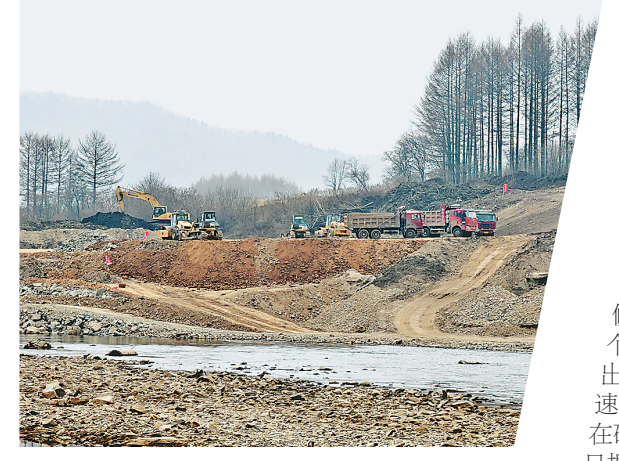
海浪河左岸施工火力全开。
