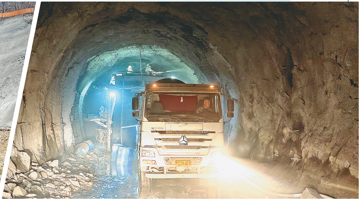
工人在洞室进行混凝土喷锚。图片均由本报记者 刘晓云摄
