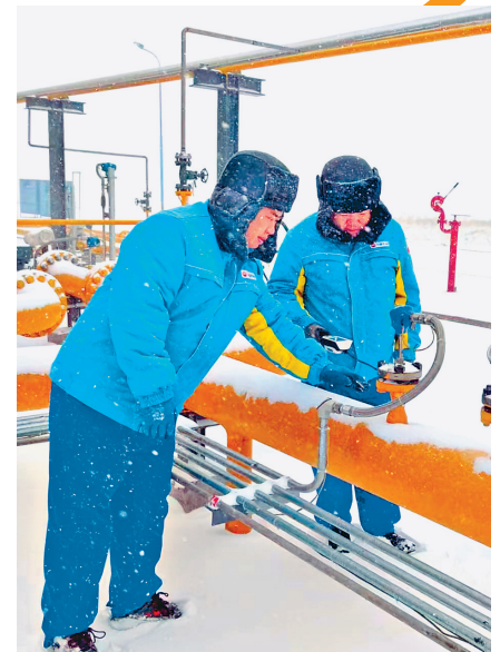
检修供气设备。 本报记者肖劲彪摄
