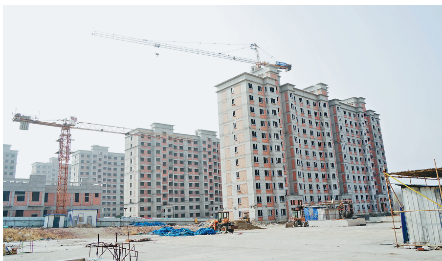
棚户区改造项目。
