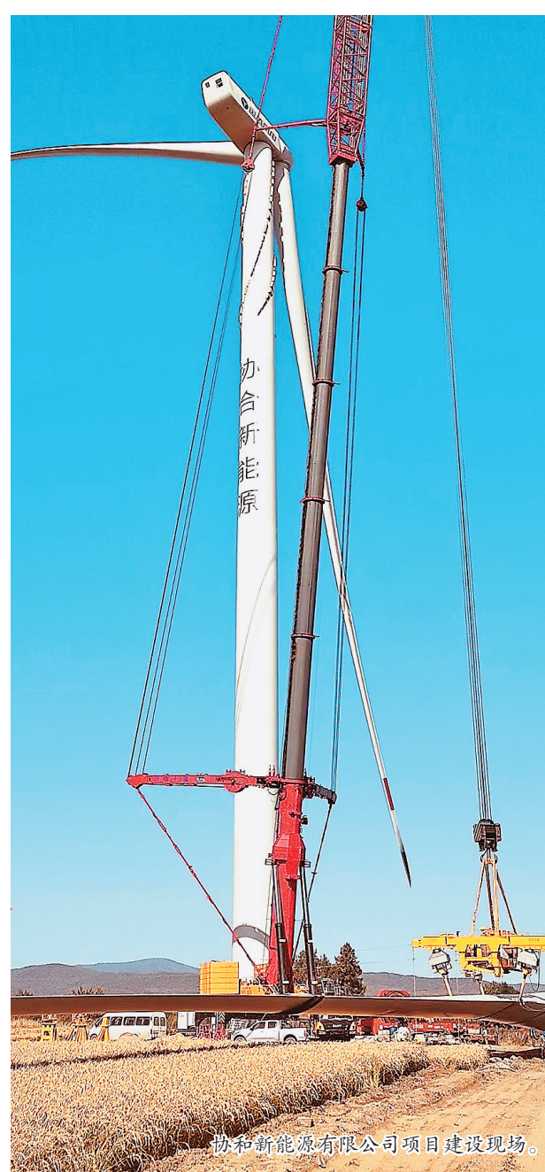
协和新能源有限公司项目建设现场。
