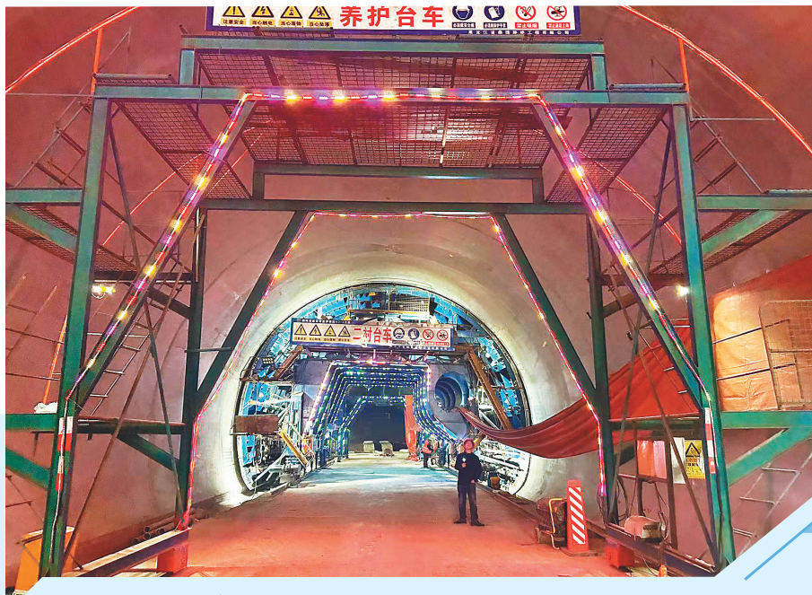
项目施工现场。
