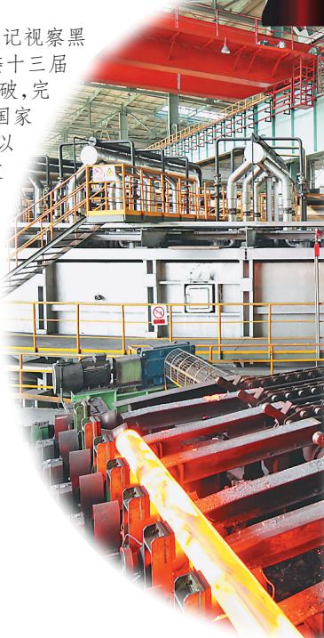
建龙钢铁生产车间。
