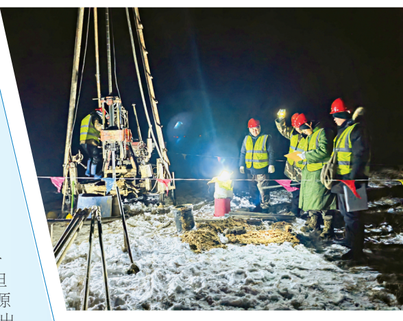
夜间钻探施工。
