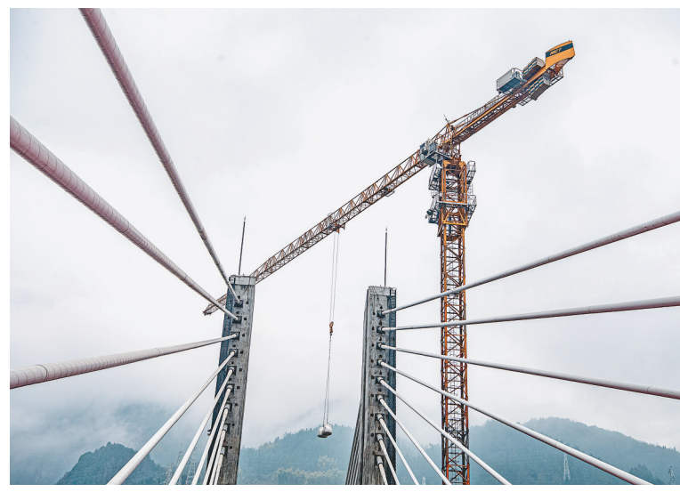
这是1月31日拍摄的渝湘高铁长途河双线大桥施工现场。当日,随着最后一节连续梁浇筑完成,由中铁二院设计、中铁七局承建的渝湘高铁重庆至黔江段长途河双线大桥顺利合龙。该桥位于重庆市黔江区,全长345.58米,为全线控制性工程之一。
