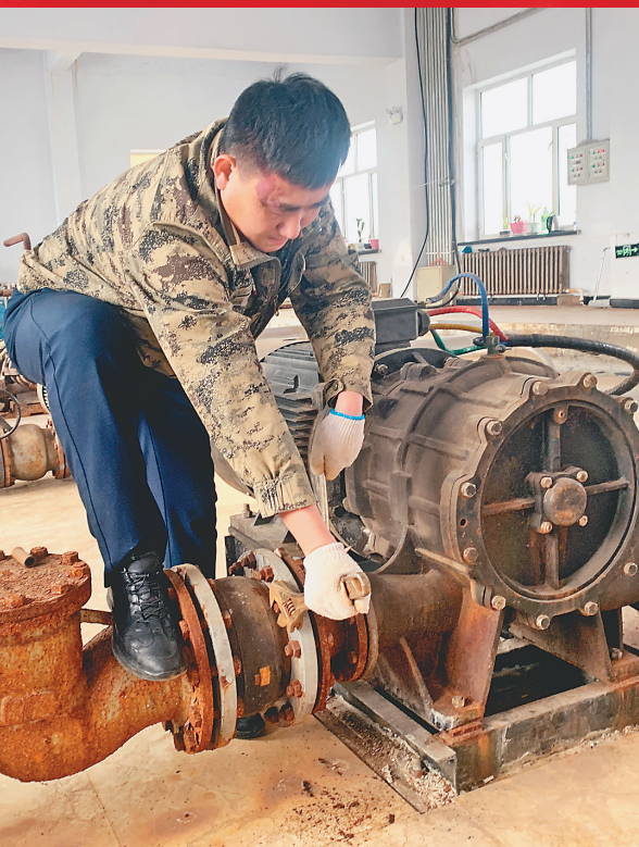
陈庆全在检修供水管线。
