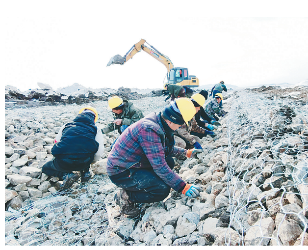
施工现场。 侯玉奇摄
